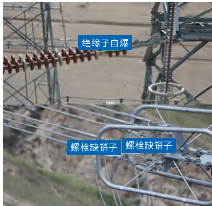
图2.11 基于图像识别技术的输电本体缺陷识别
